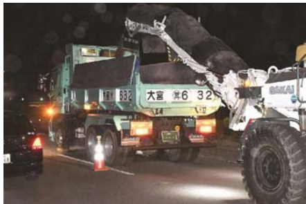
切削ガラを積み込むスケールダンプ
